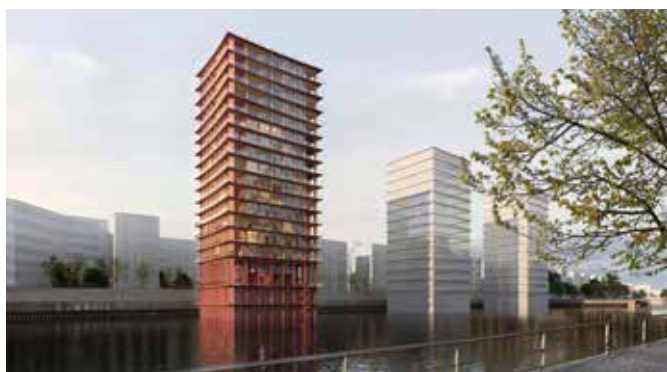
Projekt Naval: Das 13-geschossige Büro Hochhaus in Hamburg wird auf einer 2-geschossigen Tiefgarage errichtet.
