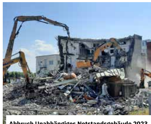
Abbruch Unabhängiges Notstandsgebäude 2023
